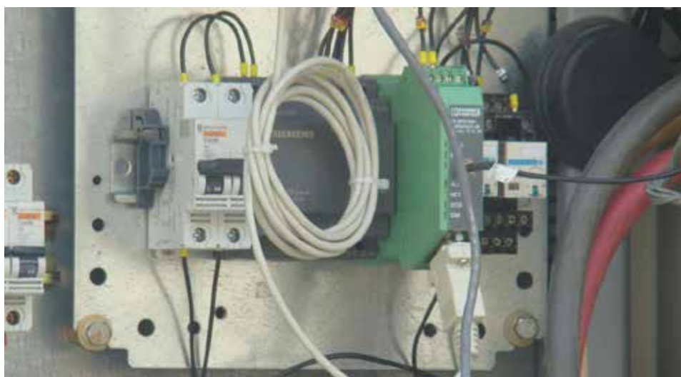
Sistema de comunicación celular Phoenix Contact.
