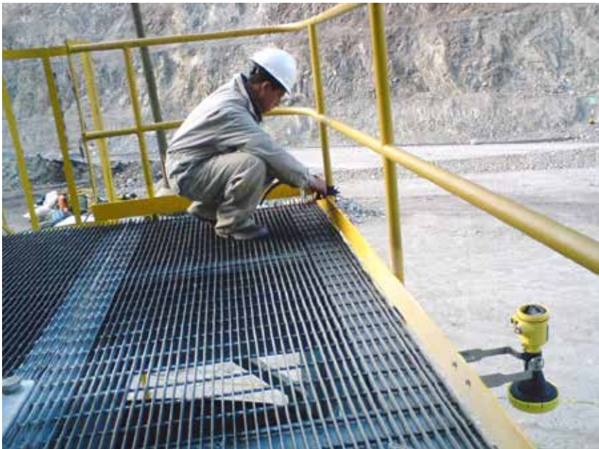
Instalación del sensor de nivel en el tanque de agua.
